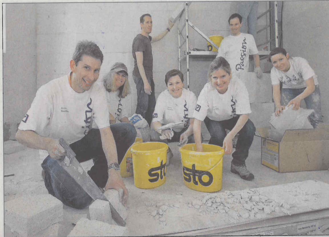
Fleißige Handwerker auf der Baustelle an der Ulmer Straße: Die Mitarbeiter der Deutschen Bank zeigen, dass sie auch zapacken können und helfen tatkräftig bei den Renovierungsarbeiten für das neue Kinderhaus. Foto: Bulgrin
